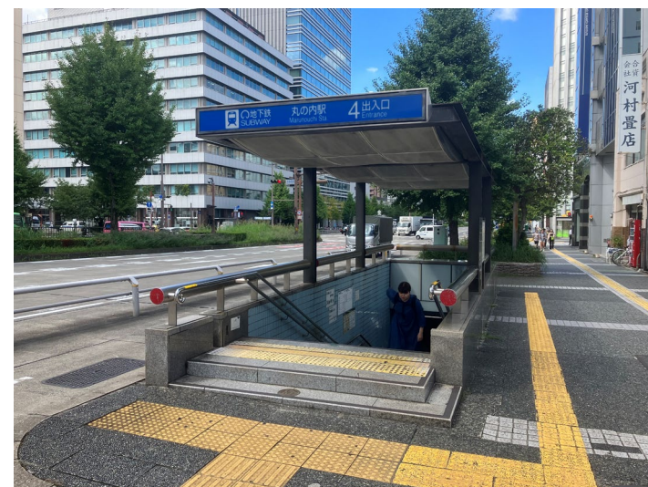
開放感のない地下と地上部の出入り口
