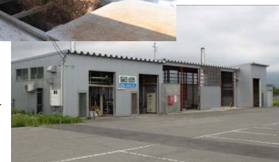
ボイラーへの搬入
