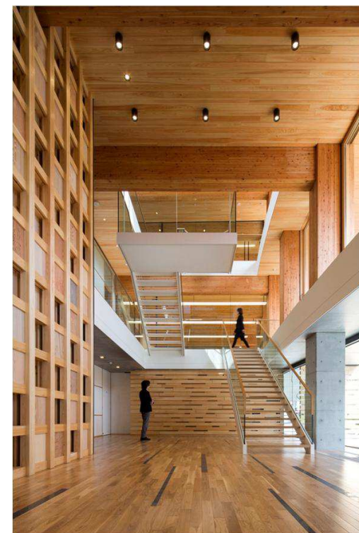
耐火集成材の採用と避難安全検証により最大限木材を活用した事例 (大阪木材仲買会館)
