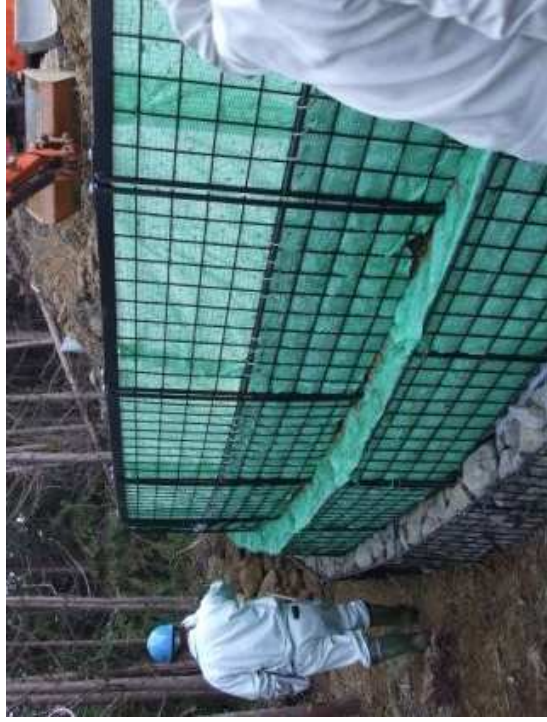
鋼製土留工の施工事例(京都府)
