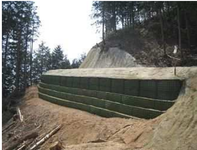
現地施工写真
