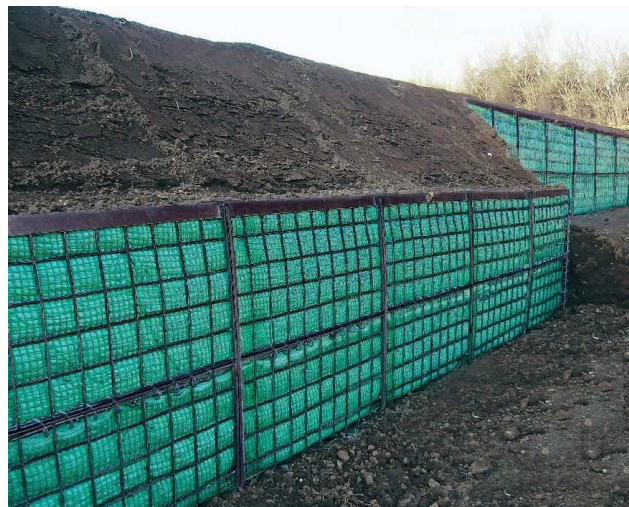
鋼製L型土留工
