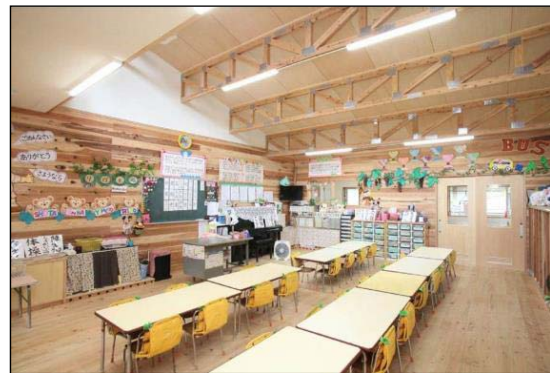
千葉県産のスギをたて枠材として使用した幼稚園（千葉県）
