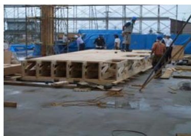
トラス地組み施工例
