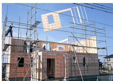
壁パネル施工例
