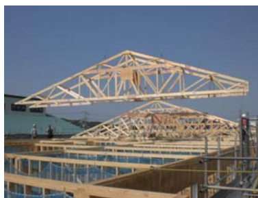
屋根トラス施工例
