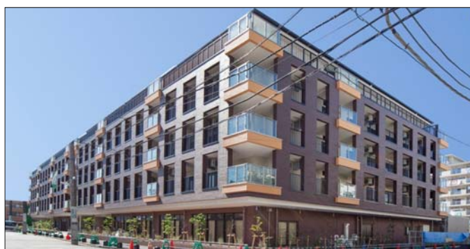
特別養護老人ホーム（東京都） 2014年度木造建築技術先導事業 (2016年6月) 5階建て（1階RC 2~5階は2x4） 延面積 9,789㎡
