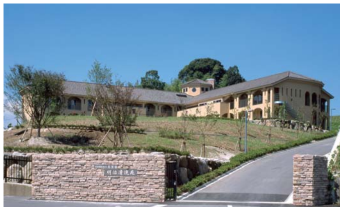
特別養護老人ホーム（大分県） (2006年7月完成) 2階建て（地階RC 1~2階は2x4） 延面積 4,469㎡
