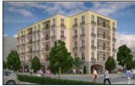
2016年度採択 5階建共同住宅（宮城県） 床にCLTを使用
