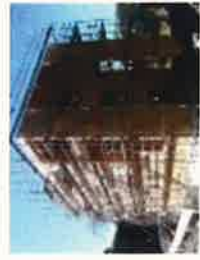
CLTの施工方法の確立及びコストダウンに向けたCLTを活用した先駆的建築物の支援
