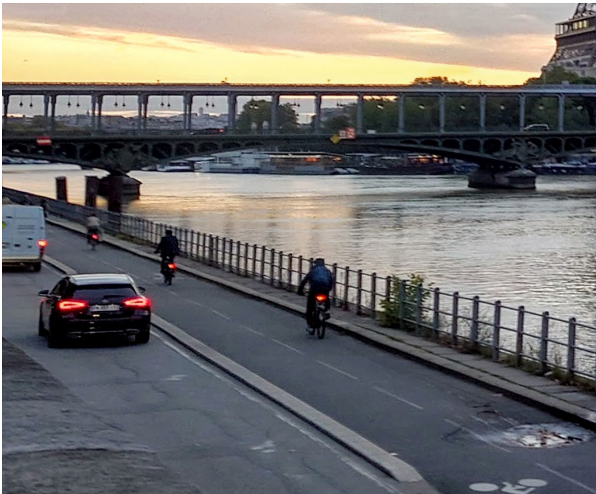
バイパス道路1車線を廃止し自転車道に付け替え 伊藤撮影
