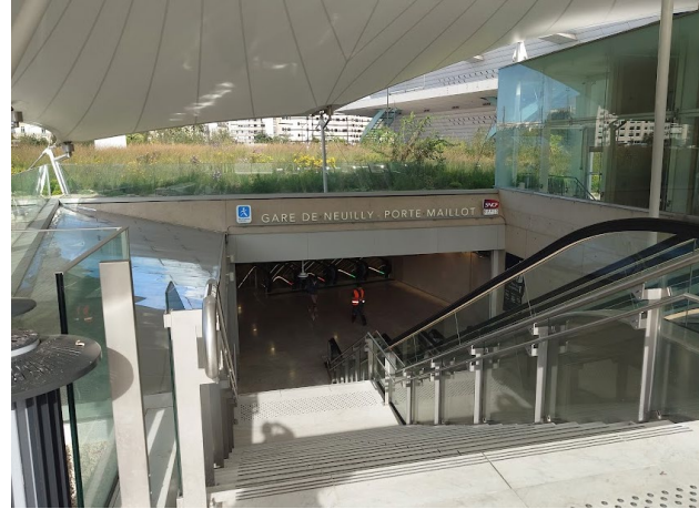
左 延伸トラムT2新駅 伊藤撮影
