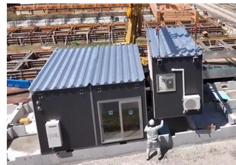
他地域で生産したユニットをクレーンで設置
